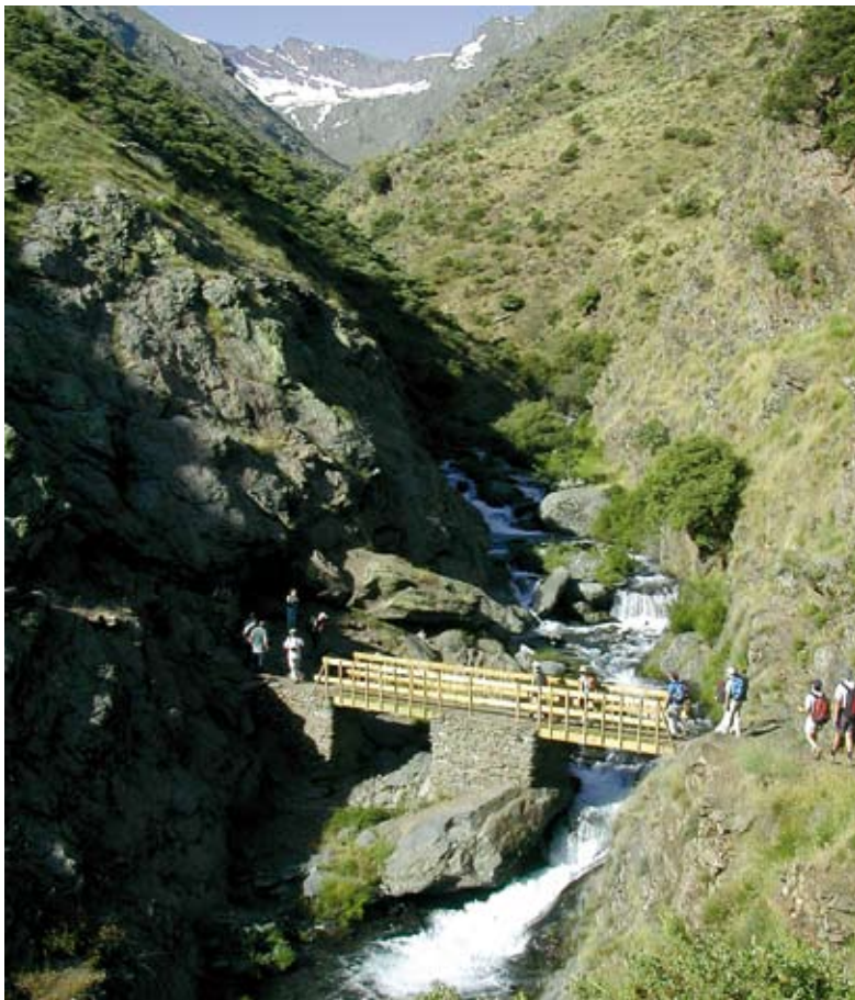
La creación de infraestructuras posibilita el acercamiento a la montaña de un mayor número de practicantes. Vereda de la estrella, "El Hornillo" (Sierra Nevada). Archivo F.A.M.
